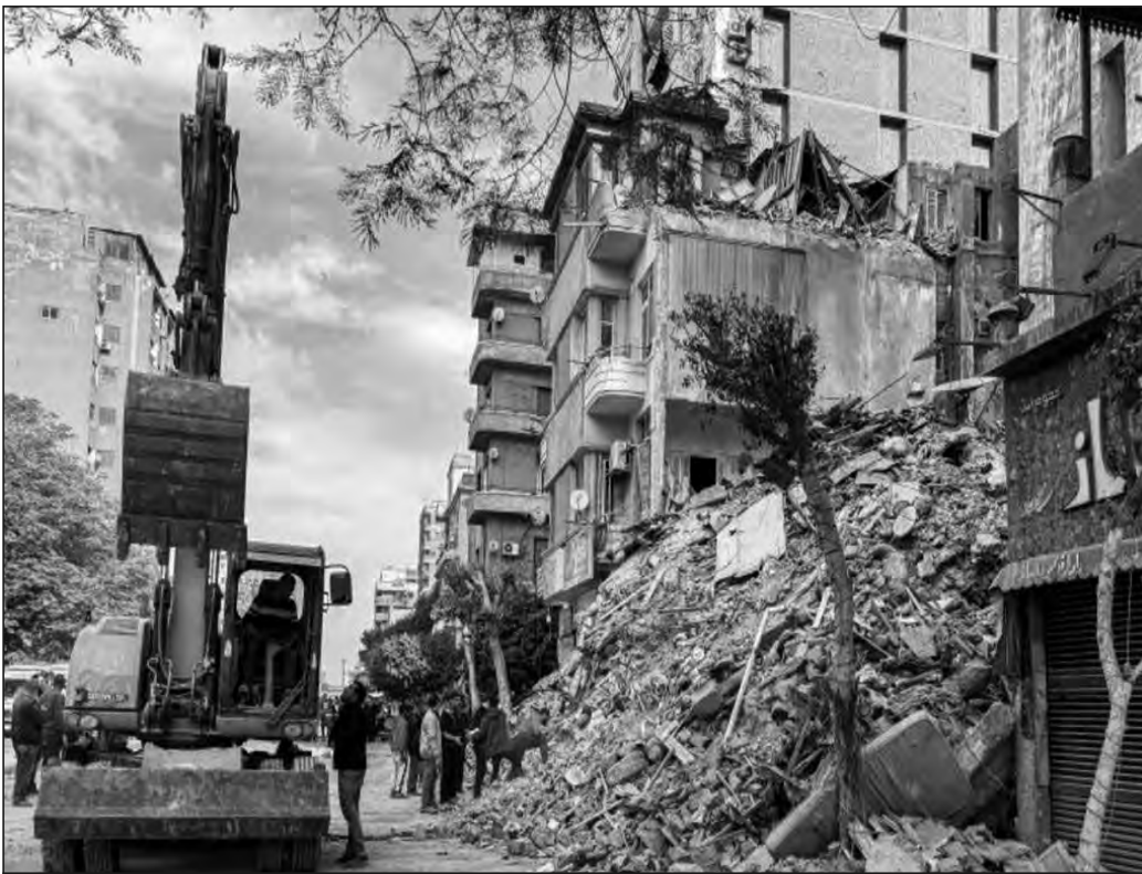
Effondrement d'un immeuble au Caire en décembre 2024
